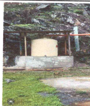
Foto 6: Construccion de base para tinaco.
