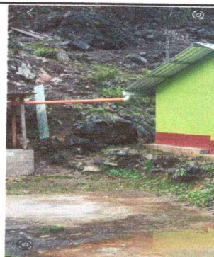
Foto 4: Colocacion final de los nuevos canales de metal
