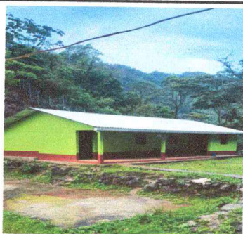
Foto 5: Pintura nueva del exterior del establecimiento.
