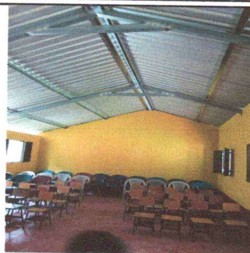
Foto 2: Colocacion final de las estructuras metalicas de tubos cuadrados.
