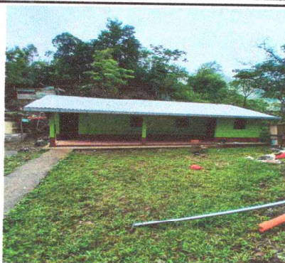
Foto1: Colocacion final de las laminas nuevas troqueladas calibre 24
